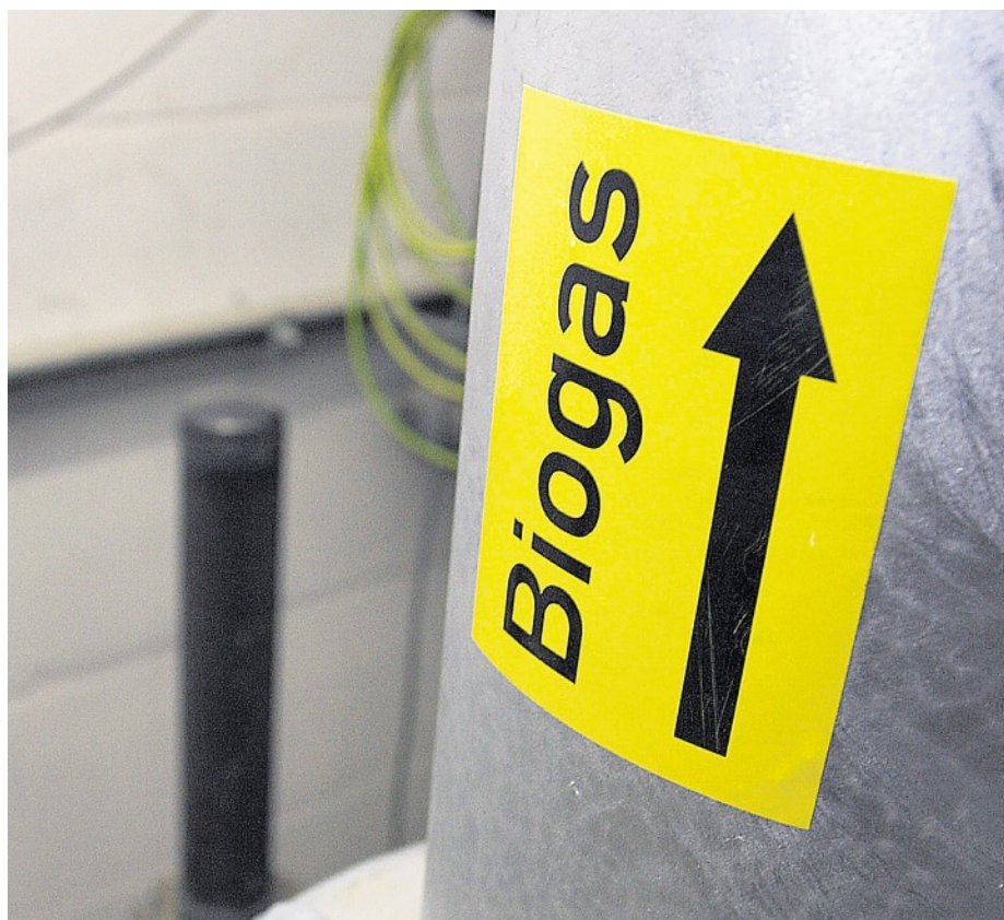
Für Biogas geht es auch aufwärts. Aber ist diese Technologie – hier ein Teil einer Biogasanlage – wirklich nur ein reiner Gewinn für die Umwelt? FOTO: ARCHIV
