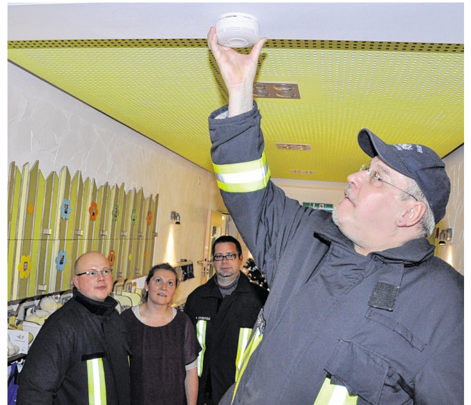
Reinhard Auer wechselt einen Rauchmelder im Flur der Kita aus.
