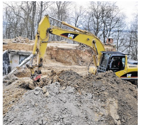
Etwa 4000 Kubikmeter Erde müssen vor dem Abriss abgetragen werden.
